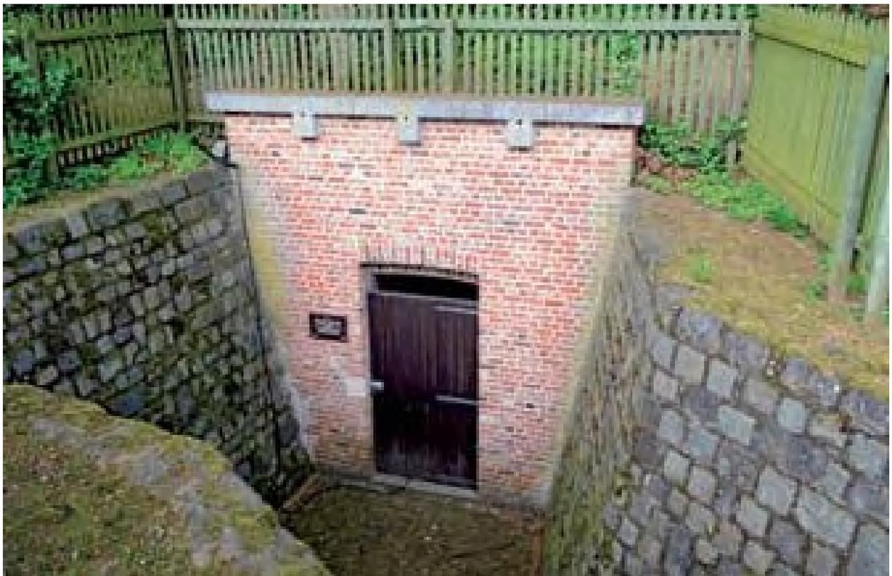
Il s'agit d'une grande cuve en briques d'Anvers liées au mortier de chaux, d'un diamètre de 4,64 m, enterrée à 2,86 m sous le niveau du terrain actuel et bien protégée des rayons du soleil par une haute futaie de hêtres. Un sas en plan incliné de 8 m de long conduit à l'entrée de la glacière proprement dite.
